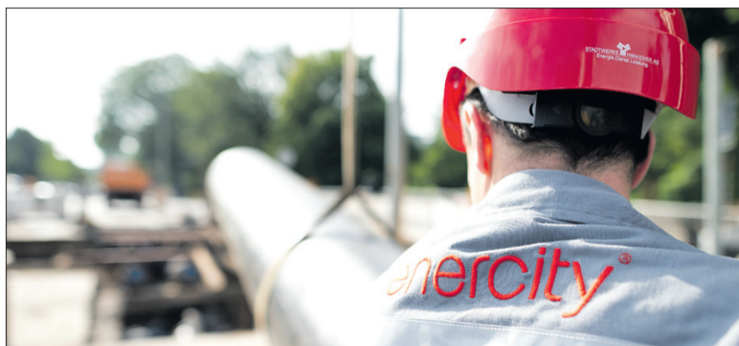
energycity schließt die Wasserstadt an das Fernwärmenetz Hannovers an.
